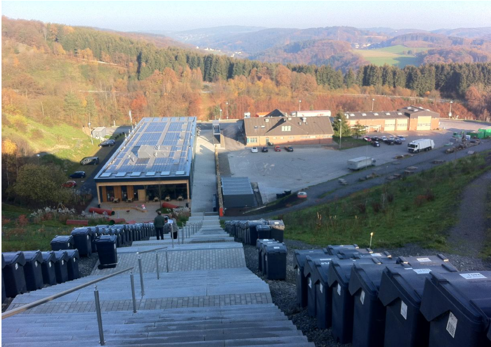
Blick auf das Gelände von :metabolon
